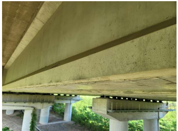
PSC Girder 전경
