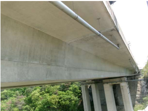
PSC BOX 외부 전경
